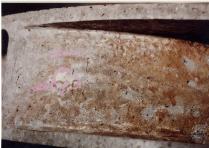
図1、高濃度残留塩素環境中におけるSCS13鋼の 全面腐食損傷
